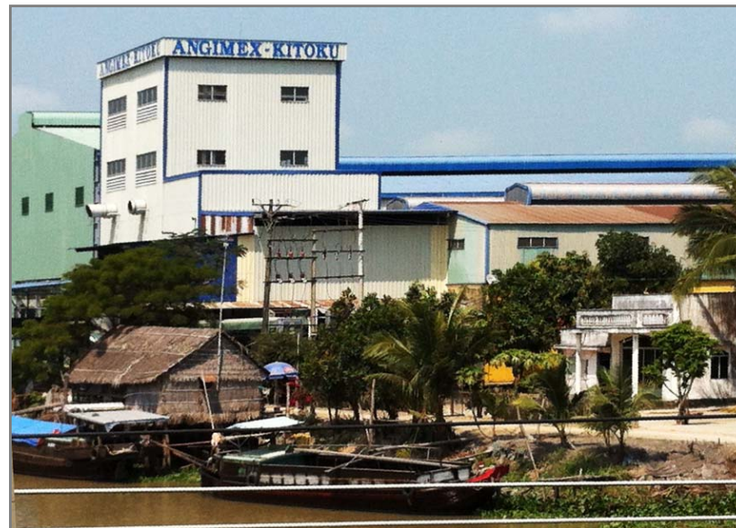
乾燥・糸摺り新設工場
