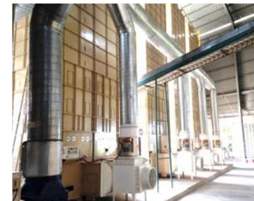
日本式乾燥設備
