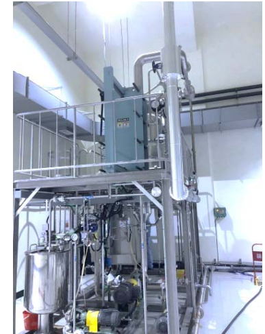
真粒米製造設備（濃縮機）
