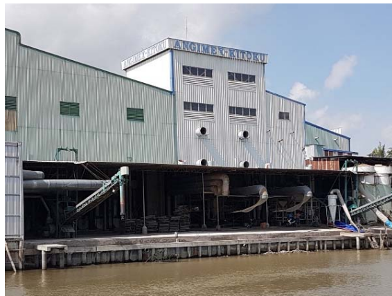
Ba the工場 着岸用岸壁補修工事
